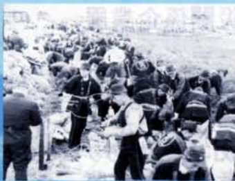
伊勢湾台風 消防団員による土嚢積
